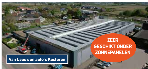
Werk in uitvoering
