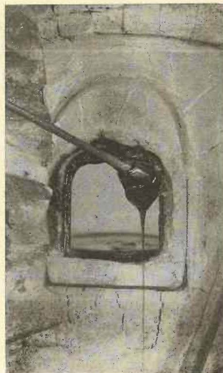
Afbeelding 9 Met de blaaspip wordt een klompje vloeibaar glas uit de oven ge- nomen
