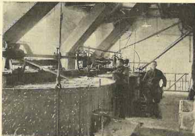
Afbeelding 3 Chaleurs of kalkstalleurs Van de diffuseurs wordt via de meetbakken en voor- warmers het suikersap naar de kalkstalleurs vervoerd Hier wordt het suikersap gemengd met ongebluste kalk
