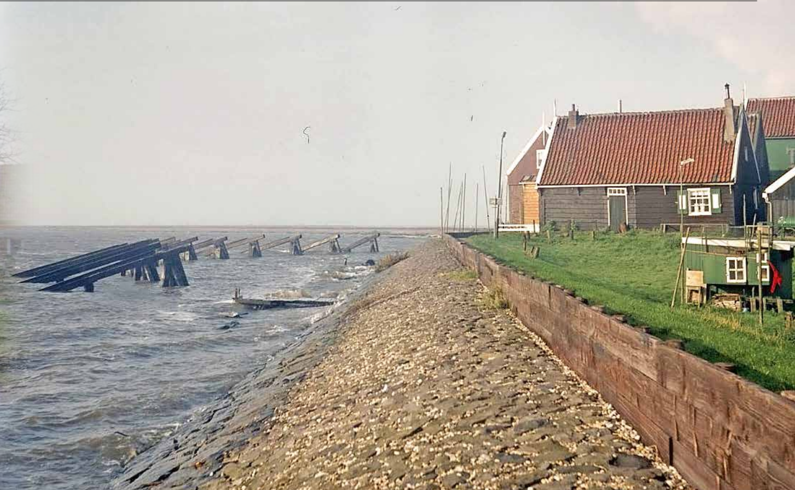
Een dijk met in het water ijsbrekers om de huizen te beschermen
