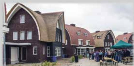
Dalemburgh te Gorinchem - nieuwbouw van 36 villawoningen
