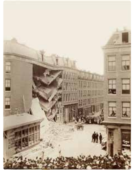
Revolutiebouw in de Dapperbuurt in Amsterdam: een huis aan de Pieter Nieuwlandstraat ingestort in 1899. De bouw van deze buurt is in 1873 begonnen en lange tijd bestond hij grotendeels uit revolutiebouw.
