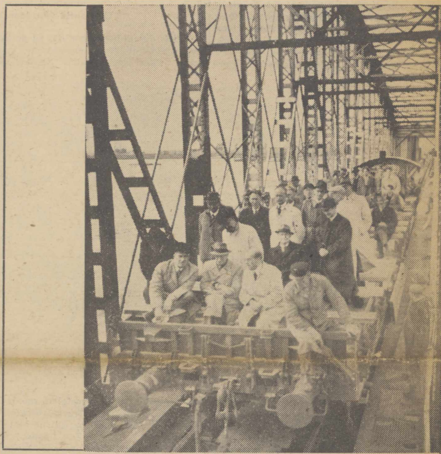
Woensdag 21 Augustus kwam wederom een schakel tusschen Noord en Zuid gereed: Men ziet hier op twee open vrachtwagens ingenieurs, technici en aannemers over de herstelde Moerdijkspoorbrug rijden. Na dit kleine treintje volgden overigens twee van de grootste locomotieven die de N.S. bezitten.
