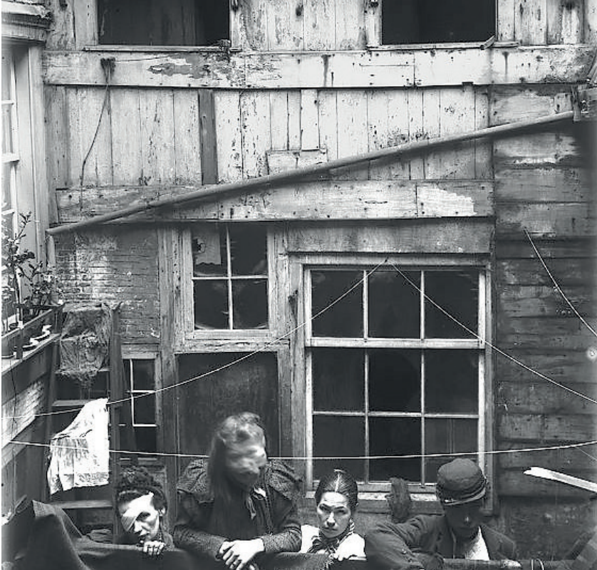
Een krotwoning in De Jordaan omstreeks 1900. Niet lang daarna verschijnen de 'arbeiderspaleizen' zoals Het Schip, foto onder.
