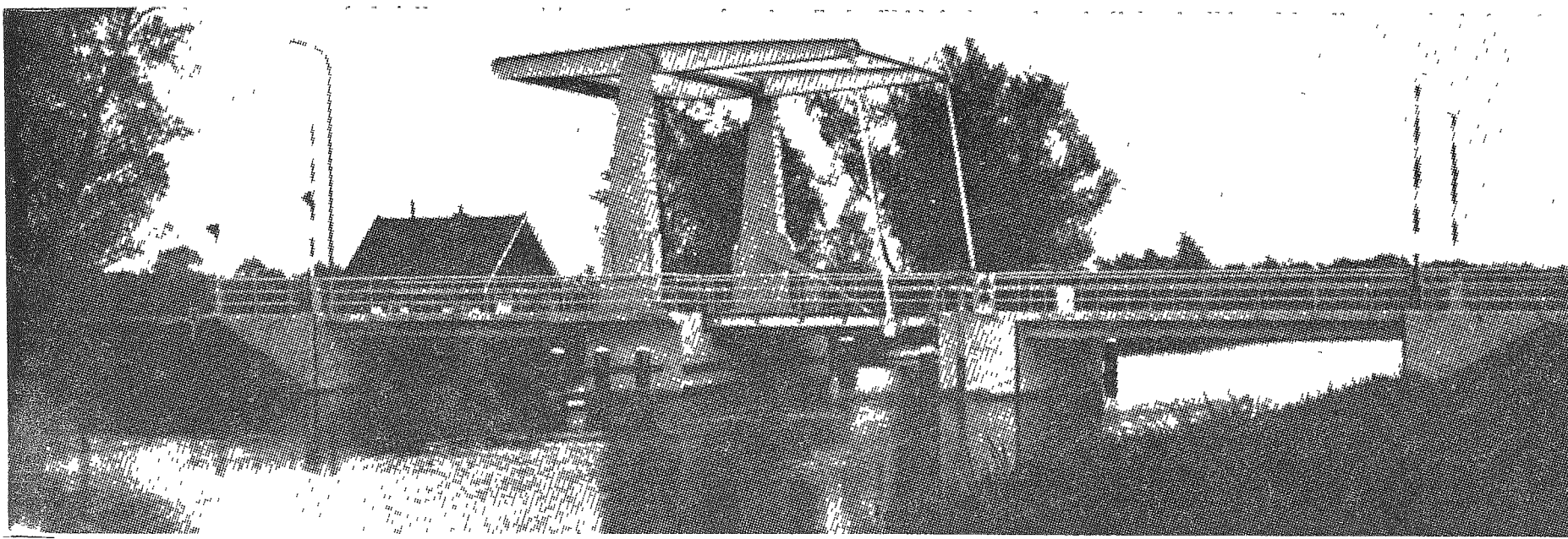
Wanneer komen de Friezen over de brug?
