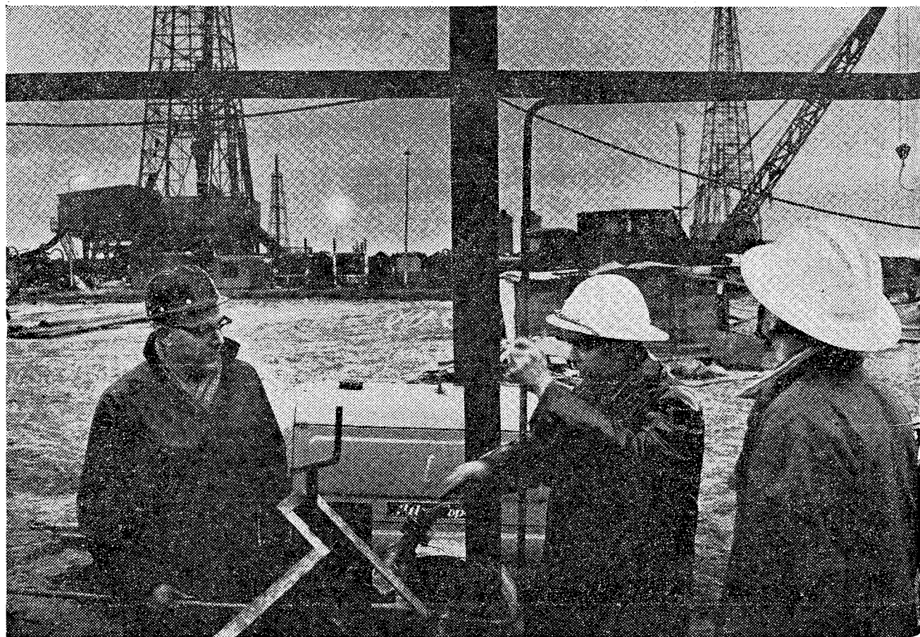
Tijdens de constructie van het aardgasveld Slochteren.
