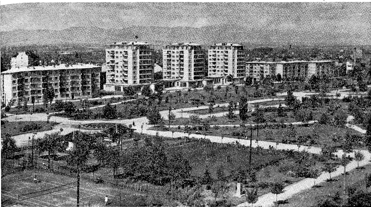
Nieuwbouw en parkaanleg in Sofia's buitenwijken. Aan de einder het Vitocha-gebergte.
