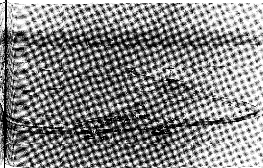
een beeld van de bouwput ten behoeve van de afsluiting van het Haringvliet
