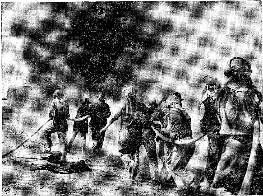
Een oliebron kan branden, dagen-, soms maandenlang. Water helpt niet, maar wel chemische brandblusmiddelen en dynamiet om een luchtledige ruimte te vormen.
