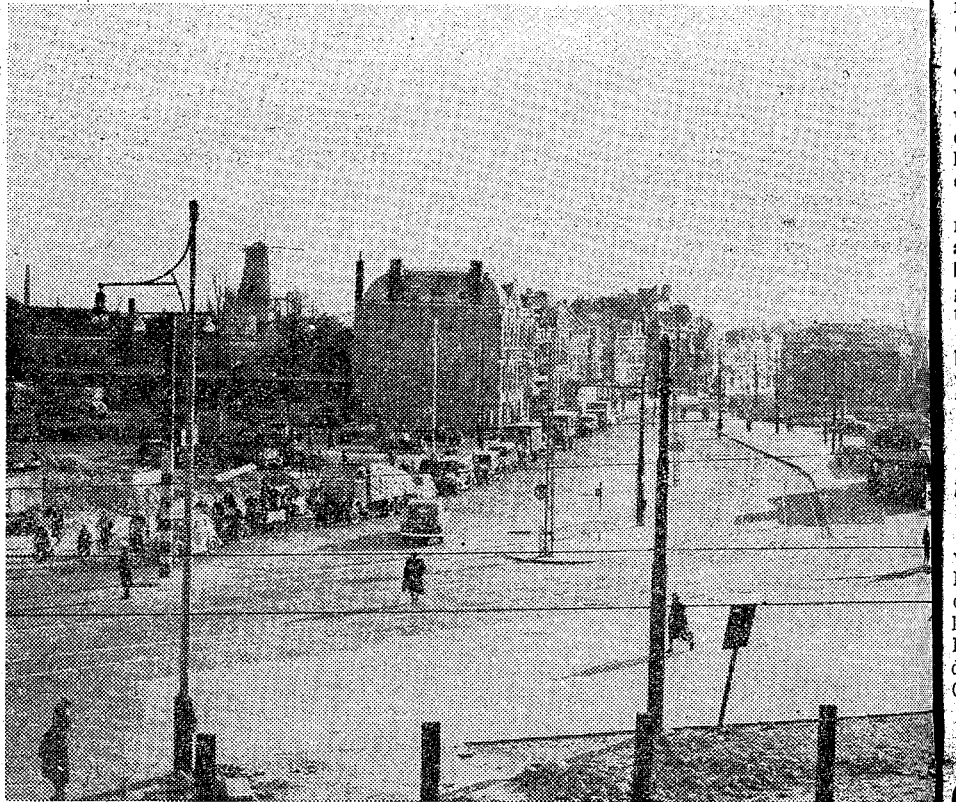
Een kijkje op de Rijnsburgerweg toen de overweg (op de voorgrond) nog was. Door de hoge frequentie van de treinenloop op de lijn Amsterdam-Wassenaar was de overweg erg vaak gesloten. In lange file's moest het verkeer wachten tot de bomen weer open gingen. Dat dit grote schade voor het wegverkeer bracht behoeft geen betoog.
