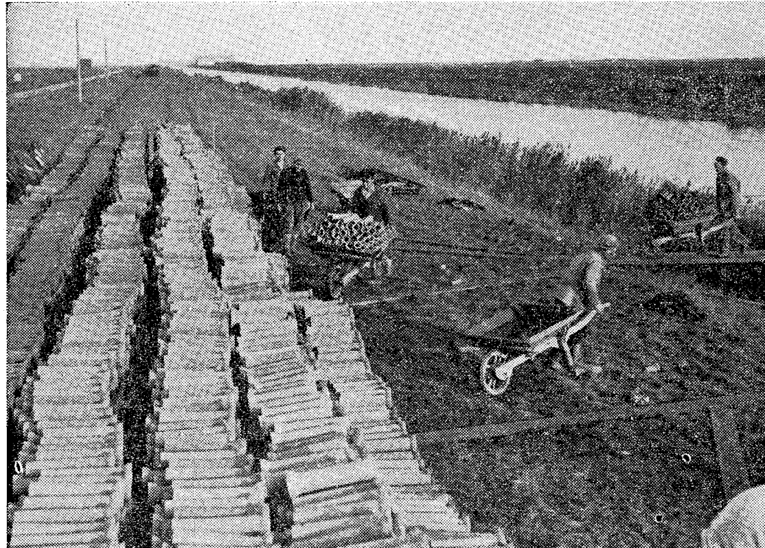
De drainering van de N.O.-polder is van groot belang. Millioenen draineerbuizen heeft men hiervoor nodig.
