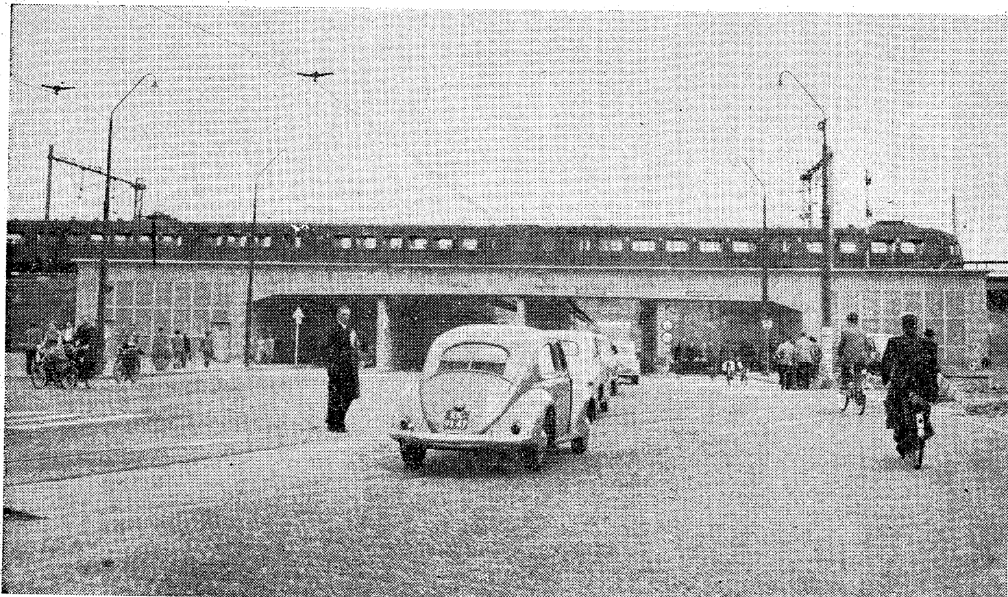
De nieuwe onderdoorgang in de Rijnsburgerweg te Leiden.
