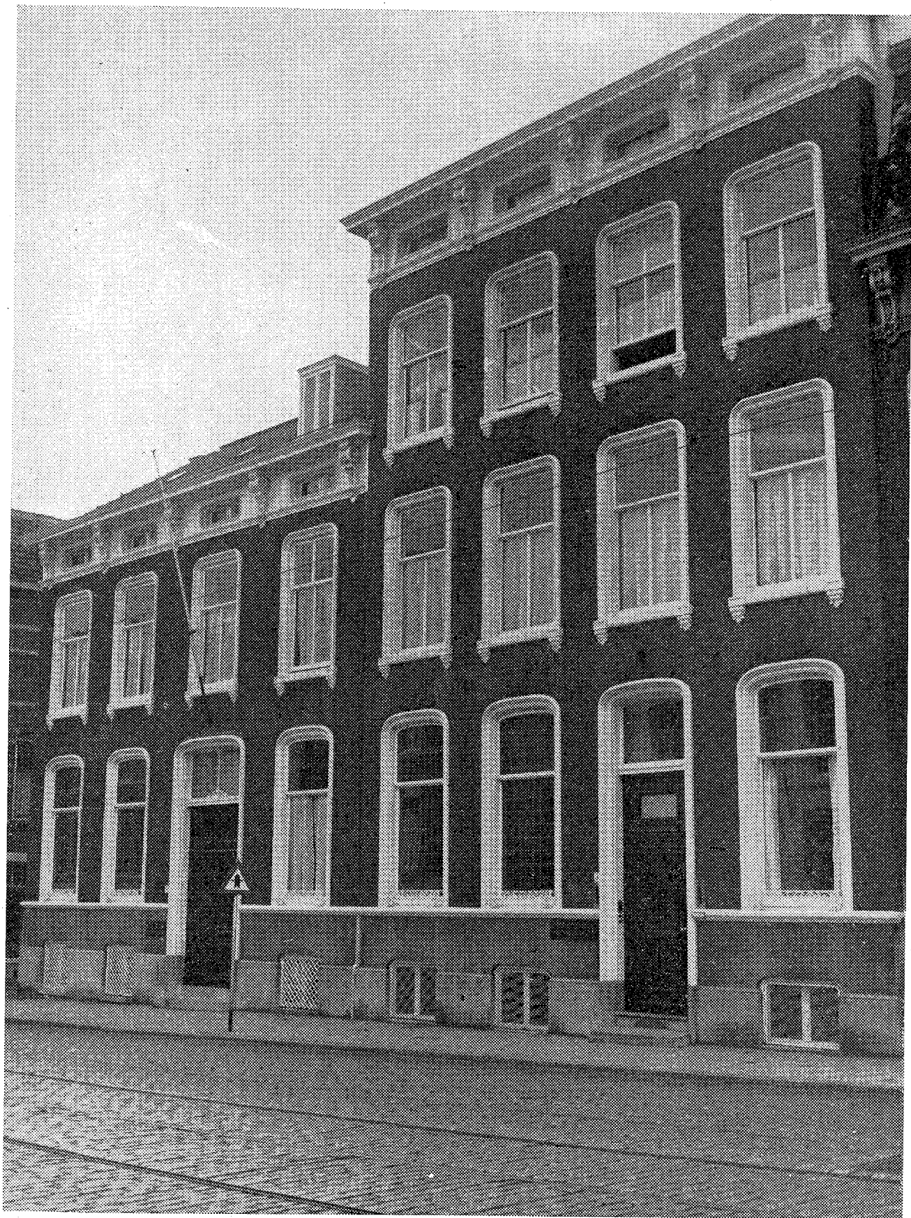
Het gebouw der Dr Kuypersstichting. Links is het voormalige woonhuis van Dr Kuyper.
