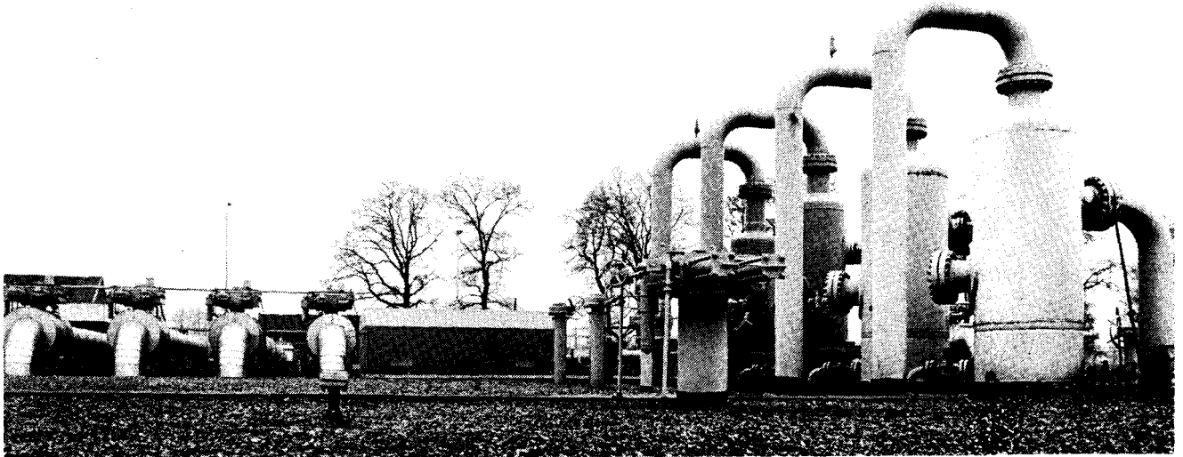
Een van de 19 gasexportstations van de N.V. Nederlandse Gasunie, waardoor in 1982 in totaal 34,8 miljard m 3 aardgas werd geëxporteerd.
