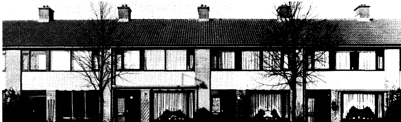
Dit is de Lindenlaan te V. Sommige bewoners in deze straat denken dat dubbele ramen en spouwmuur-isolatie er nooit uit zullen komen.
