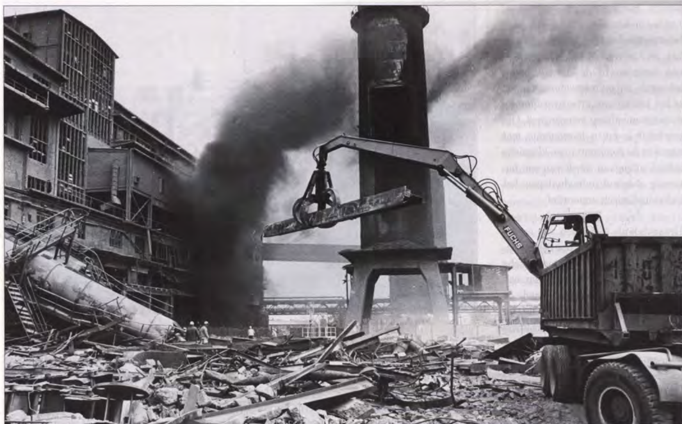
Creative destructie: de sloop van een fabriek in Oost-Duitsland schept ruimte voor nieuwe ontwikkeling
